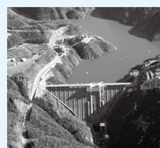
▲上空から見た小里川ダム
