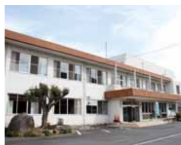
▲改修する東野コミュニティセンター
