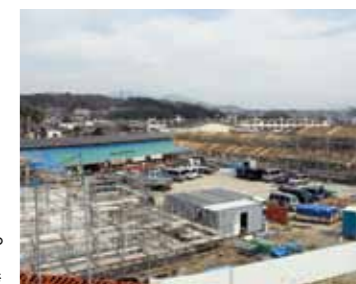
▲建設が進むおさしま二葉こども園
