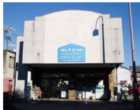
▲サポートセンターの外観
