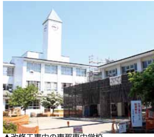
▲改修工事中の恵那東中学校
