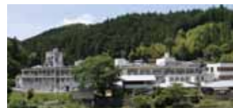
▲自然に囲まれた国保上矢作病院
