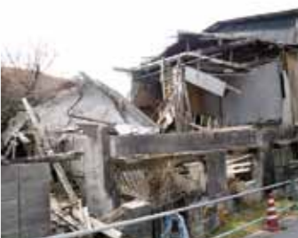
▲解体を行う特定空き家
