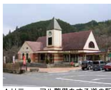
▲リニューアル整備をする道の駅上矢作ラ・フォーレ福寿の里
