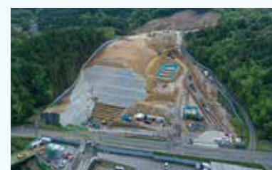
▲日吉トンネルの施工ヤード整備工事
