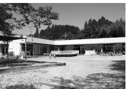
▲佐々良木保育園との統合により来年4月から「みさと保育園」となる野井保育園
