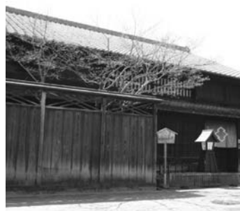
▲塗り直しを行うひし屋資料館
