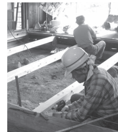
▲居住できるよう空き家を改修
