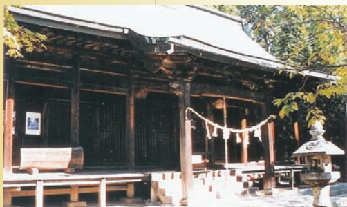
▲県の重要文化財にも指定されている社殿
