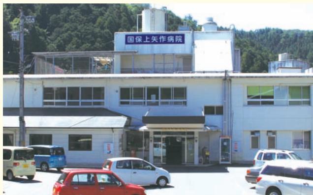
▲昭和52年に開院した国保上矢作病院
