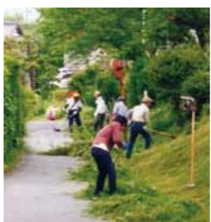
▲路肩の草刈り作業を行う
