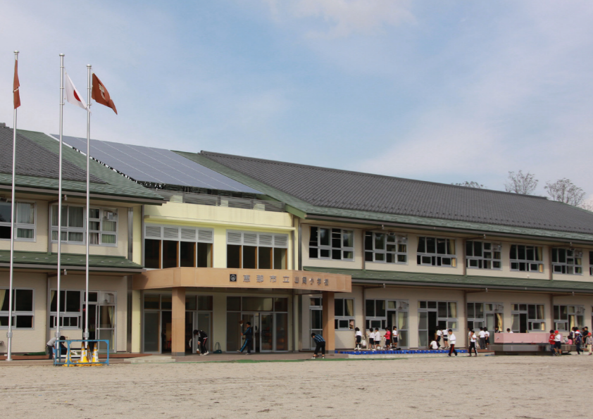
▲新たに完成した山岡小学校
