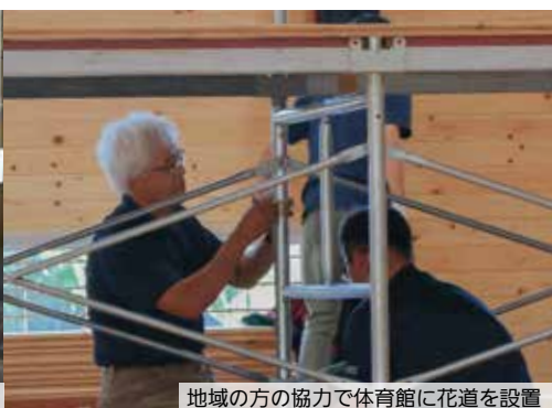
地域の方の協力で体育館に花道を設置
