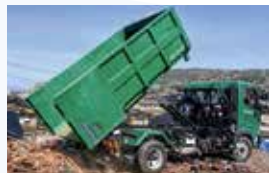
▲落下した瓦を仮置き場に運ぶ（輪島市門前町黒島町）
