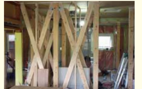
▲木造住宅耐震化補強工事
