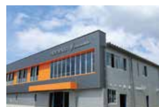
令和6年11月操業予定 建設中の新社屋
