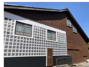
工事完了後の様子
