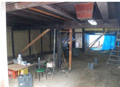
修理中の建物(内部)
