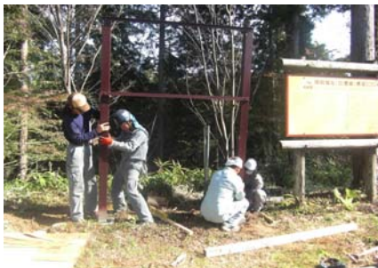
明知城跡(明智町)本丸説明板更新工事立会写真
