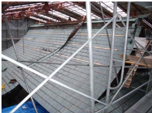
進められる保存修理の様子②
