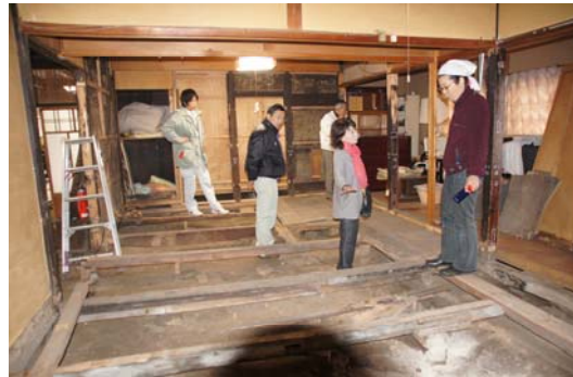
建物調査の様子
