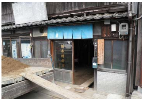
修理中の建物(外観)
