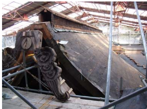
進められる保存修理の様子③
