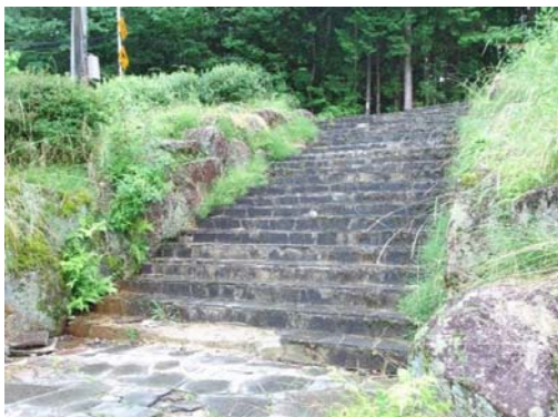
甚平坂公園(修繕前)
