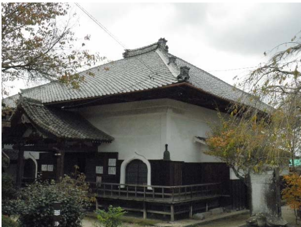
浄光寺(修理前)
