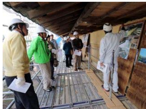
改修が進む市指定有形文化財(浄光寺)の現場見学会 施工前と写真で比較しながら説明
