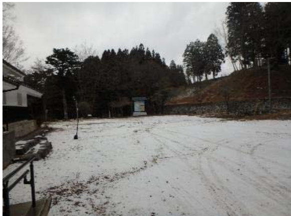
出丸広場舗装 施行前
