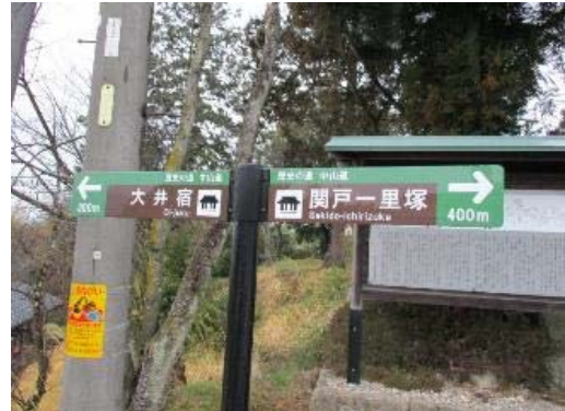
⑭矢羽型撤去・新設(支柱あり) 完成
