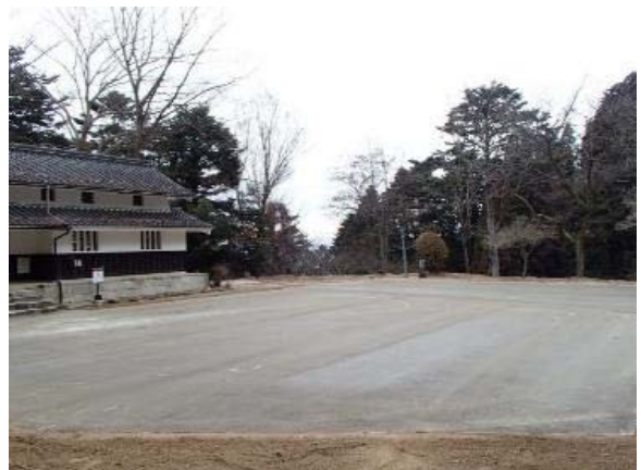
出丸広場舗装 施行後
