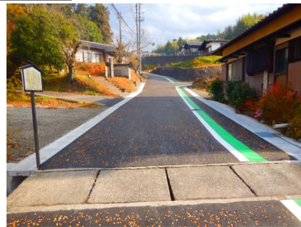
施工後の様子
