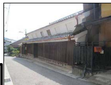
岩村藩鉄砲鍛冶加納家の修理
