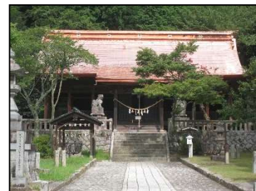
大規模修理を行った八王子神社 拝殿
