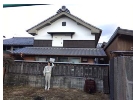
修理事例(修理後)
