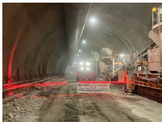
トンネル掘削作業状況
