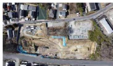
大井非常口ヤード全景（写真）
