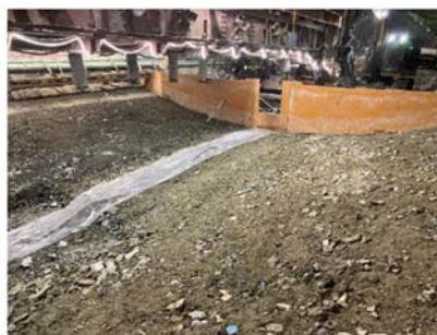
インパート作業状況 （掘削完了状況）
