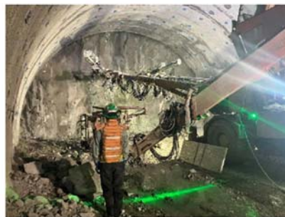
トンネル掘削作業状況 （削孔状況）
