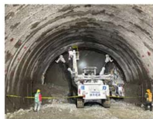
トンネル内施工状況
