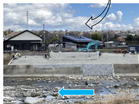
右岸橋台工事
