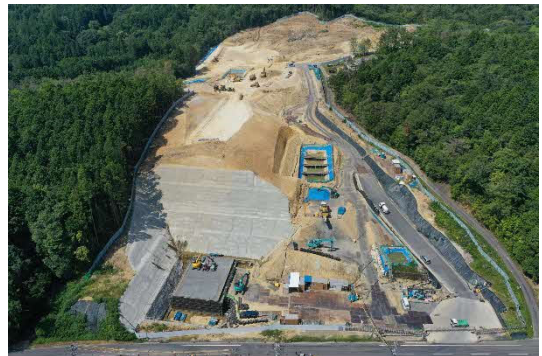
ヤード整備工
