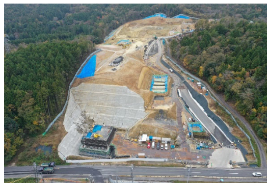
ヤード整備工
