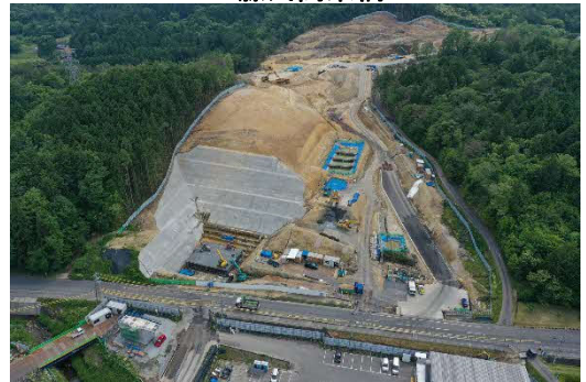
ヤード整備工
