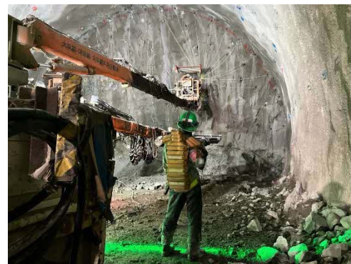
トンネル掘削作業状況 （装束状況）
