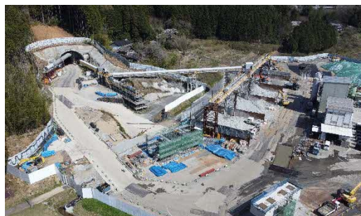
ヤード全景（名古屋方）
