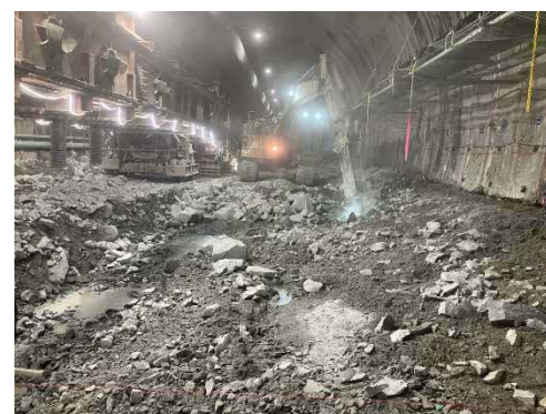
インバート工作業状況 （掘削状況）
