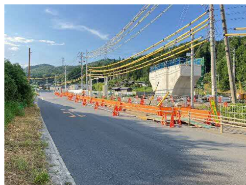
側交互規制状況 （現場出入口）
