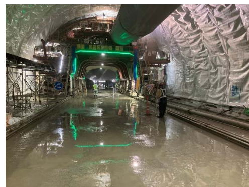
覆工コンクリート作業状況 （移動式型枠（セントル）据付状況）
