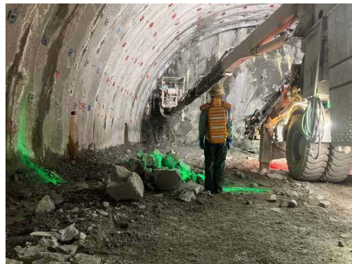
トンネル掘削作業状況（装薬状況）
