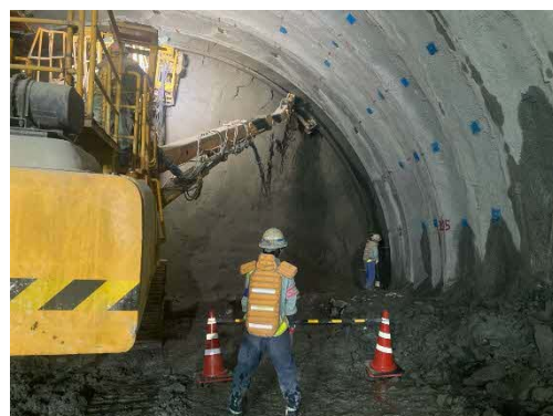
トンネル掘削作業状況 （鋼製支保工建込状況）
