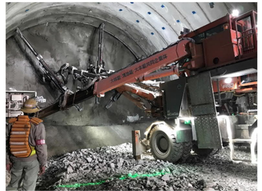
トンネル工事施工状況
