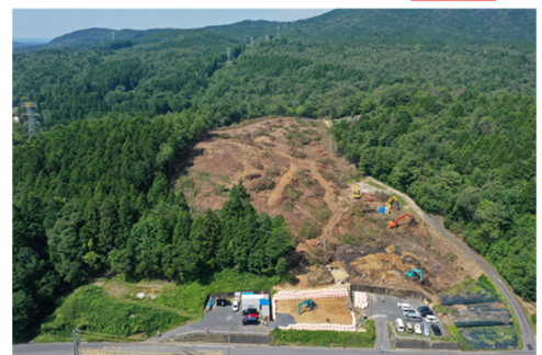
ヤード整備工
