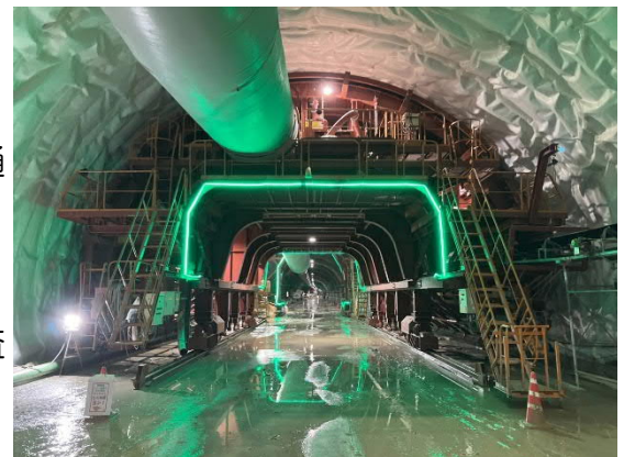
覆工用型枠（セントル）
