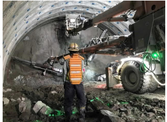
トンネル掘削状況
