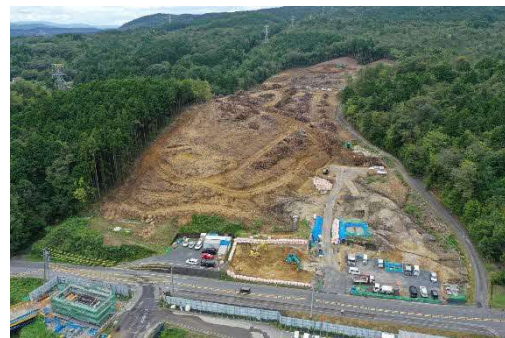
ヤード整備工
