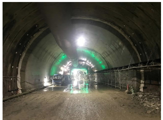
覆工コンクリート打設完了区間
