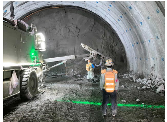
トンネル掘削作業状況（コンクリート吹付）
