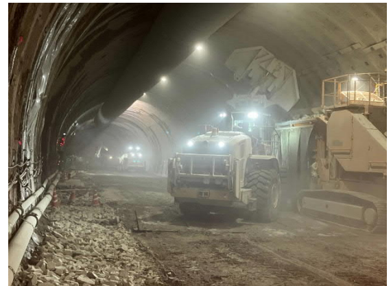
トンネル掘削作業状況（すり出し）
