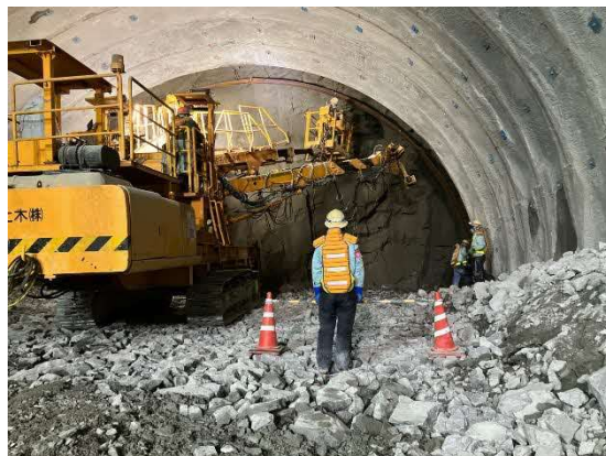
トンネル掘削作業状況（鋼製支保工建込）
