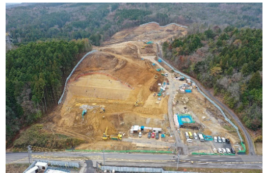
ヤード整備工
