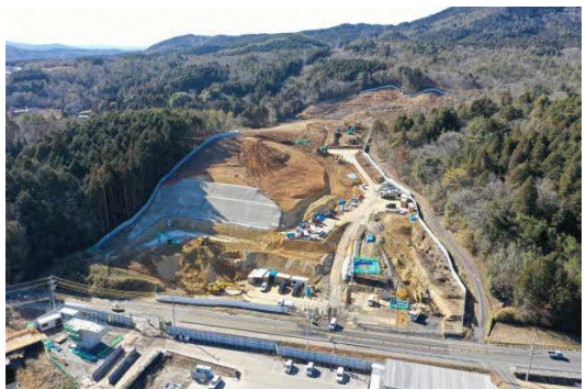
ヤード整備工
