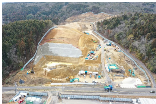
ヤード整備工
