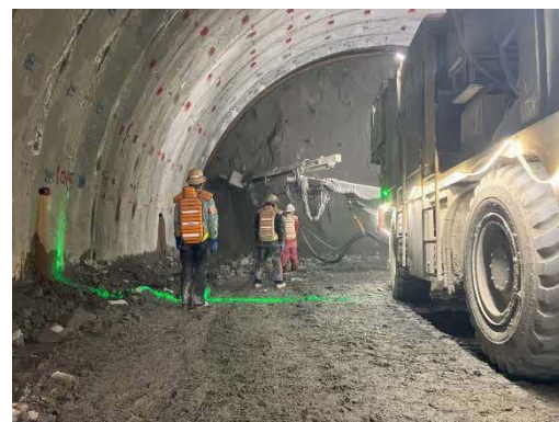
トンネル掘削作業状況（コンクリート吹付状況）
