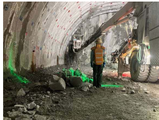
トンネル掘削作業状況（装薬状況）
