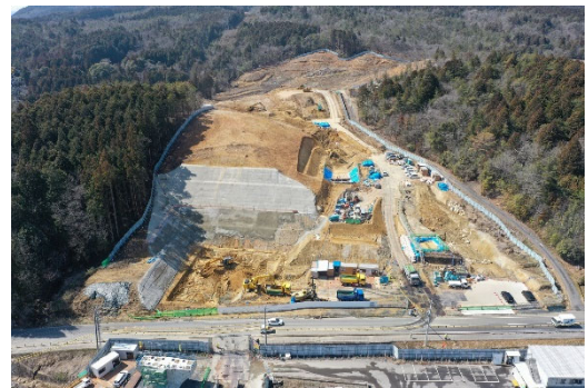
ヤード整備工
