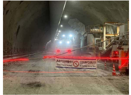
トンネル掘削作業状況（すり出し状況）
