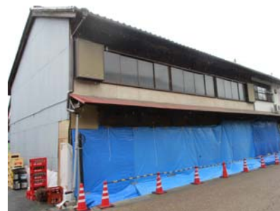
修理事例(修理後)
