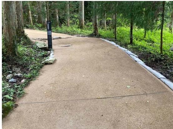
三重櫓付近の舗装工事
