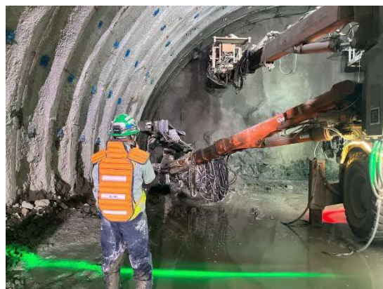
トンネル掘削作業状況 （ロックボルト打設状況）
