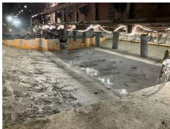
インバート工作業状況 （コンクリート打設完了）
