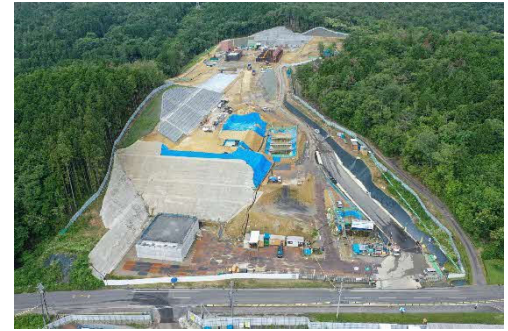
ヤード整備工
