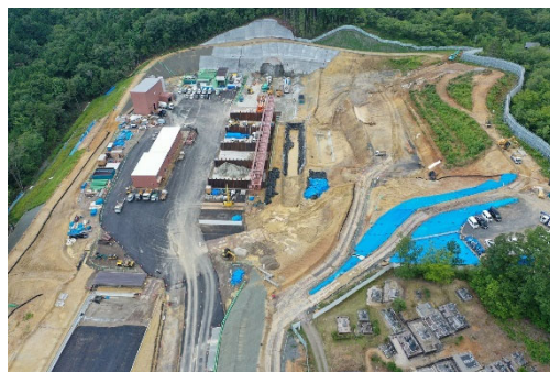
トンネル工（坑口側ヤード）
