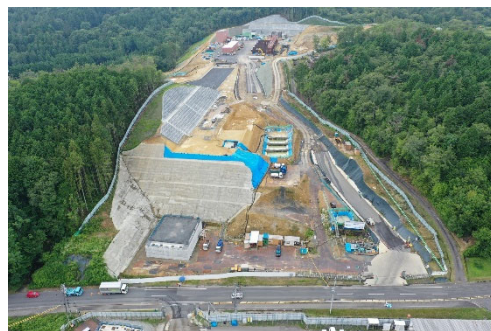
ヤード整備工
