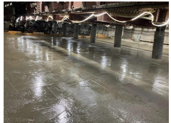
インバート工作業状況 （コンクリート打設完了状況）
