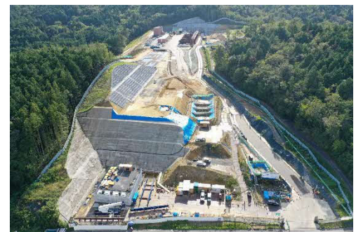
ヤード整備工
