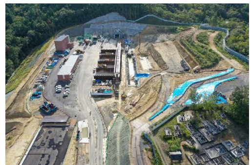
トンネル工（坑口側ヤード）
