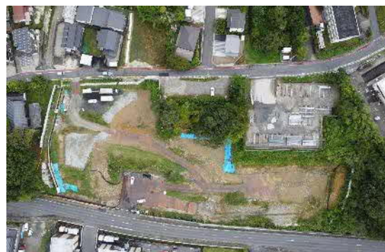
大井非常口ヤード全景（写真）
