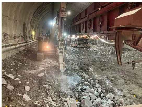
インバート工作業状況 （掘削状況）
