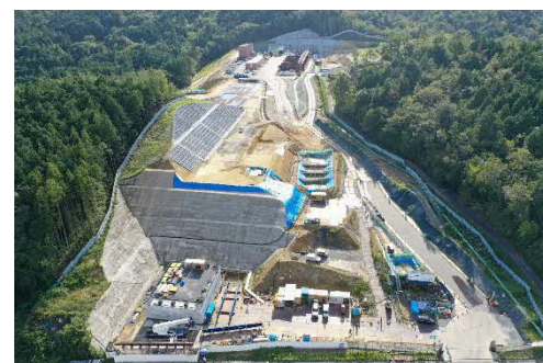
ヤード整備工
