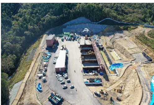
トンネル工（坑口側ヤード）
