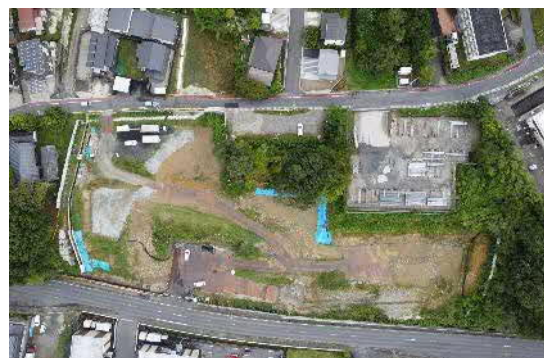
大井非常口ヤード全景（写真）
