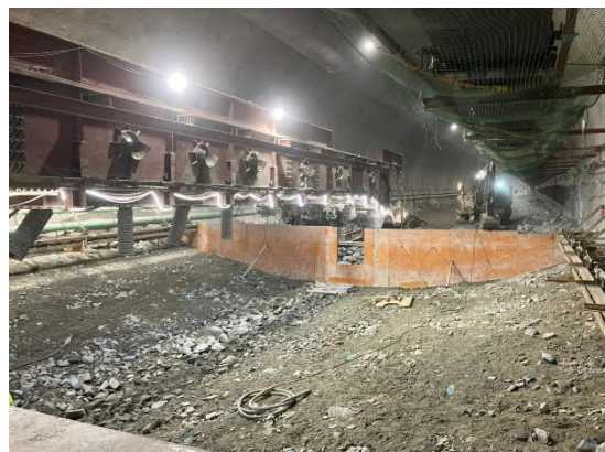
インバート工作業状況 （コンクリート打設前状況）
