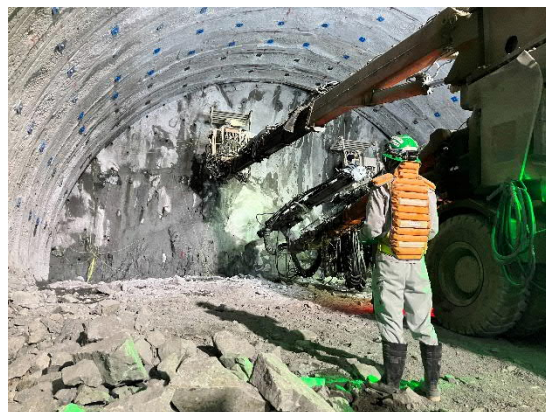
トンネル掘削作業状況 （装薬状況）
